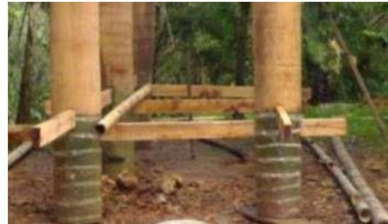
**Gambar 8.** Perakitan tiang lumbung padi dengan metode pen dan lubang
